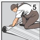
**5** После образования поверхностной пленки уложите покрытие и хорошо притрите, особенно в области стыков. Сварку стыков производите не ранее 48 часов. Полная нагрузка на поверхность возможна через 72 часа после приклеивания.
