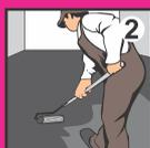
**2** Для создания впитывающего слоя, нанесите на подготовленное основание самовыравнивающуюся смесь для пола БОЛАРС слоем 2-3 мм. Укладка напольного покрытия непосредственно на загрунтованное основание не рекомендуется.
