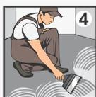
**4** Перед началом работы клей тщательно перемешайте. Нанесите клей зубчатым шпателем А2 (для гладкой основы) или В1 (для рельефной основы) по всей плоскости пола и оставьте для подсушки на 5-20 минут.
