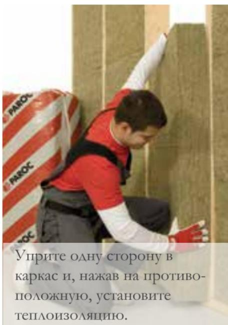
Уприте одну сторону в каркас и, нажав на противоположную, установите теплоизоляцию.
