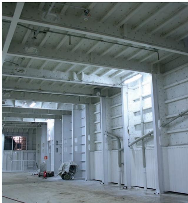
Противопожарная изоляция на судах должна соответствовать высоким требованиям. Более того, функциональность совместно с легкостью монтажа изоляции становится все важнее. Чтобы отвечать этим требованиям, необходимы альтернативные решения для различных областей применения, где необходима пожарная безопасность.
