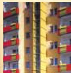
использовании легких панелей Рагос, прочности старого каркаса и фундаментов в большинстве случаев достаточно и они могут быть оставлены без изменений, а фасад получит новую высококачественную отделку.
